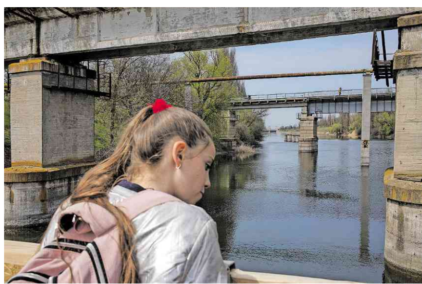
Am Nord-Krim-Kanal: Das Wasser kommt nicht mehr bis zur Krim.
